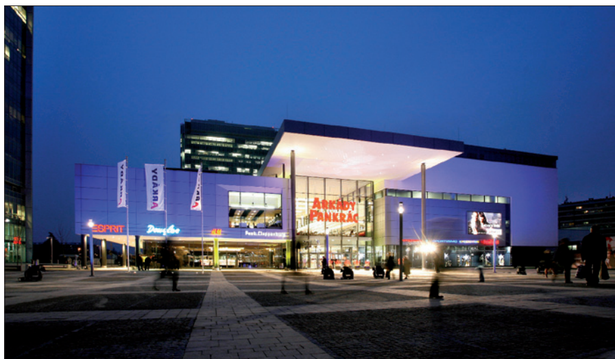
Obr. 4. Nákupní centrum Arkády Pankrác – centralizované řešení CEAG
