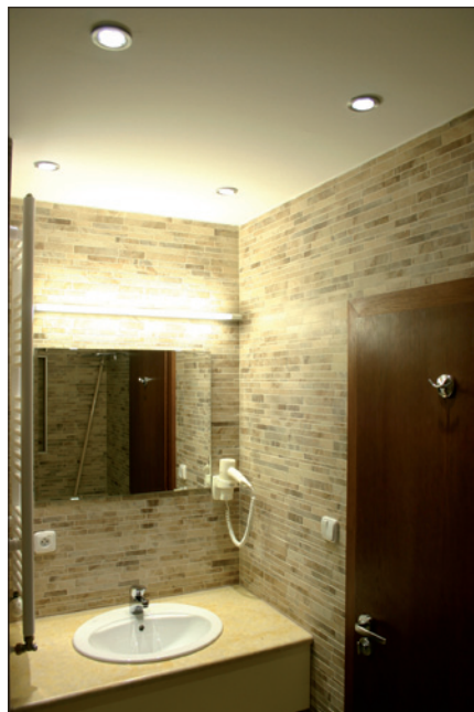
Obr. 2. Kúpeľňa je osvetlená svietidlom Mini Pentura a zapustenými svietidlami Spot LED
