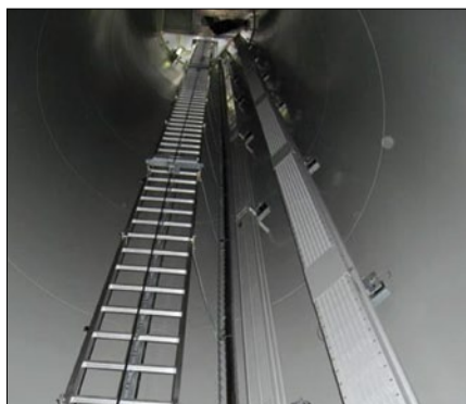
Obr. 2. Přípojniová trasa v tubusu větrné elektrárny
