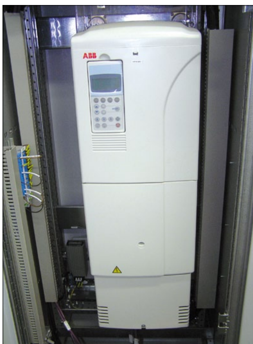
Obr. 2. ACS 800 v rozváděči MNS – pojezd hlavního podvozku na dole Sibovc v Kosovu
