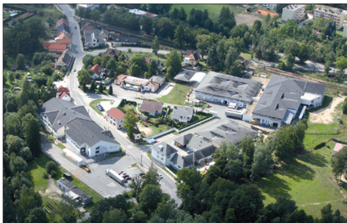
Obr. 1. Letecký pohled na výrobní závod Moeller v Suchdole
