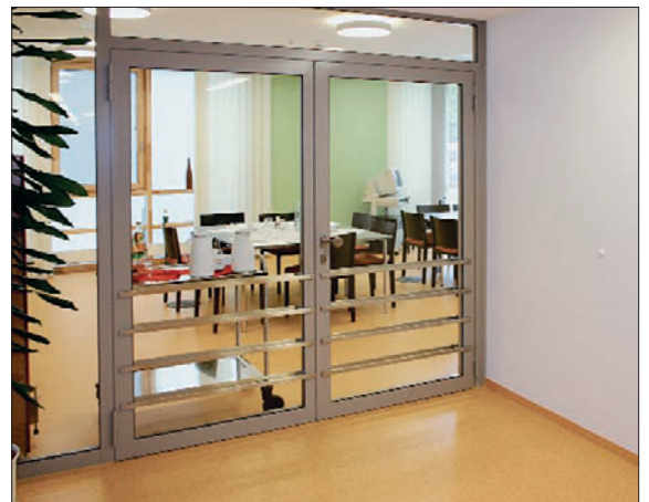
Obr. 2. Uzavírání oddělení, resp. chodeb představuje druhý nejdůležitější typ dveří v nemocničních objektech (jedno- nebo dvoukřídlé dveře ze skla a kovu)
