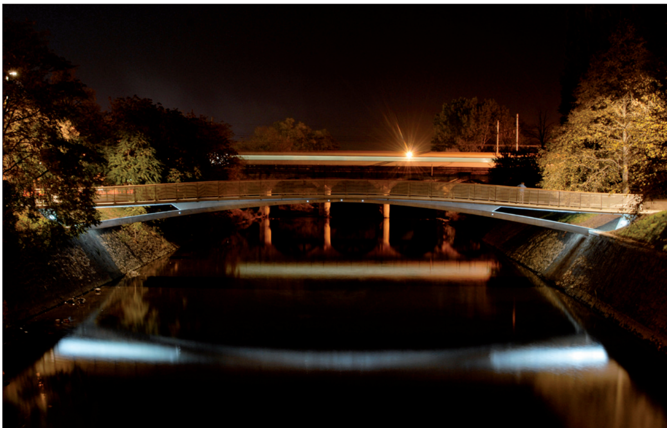
Obr. 2. Lávka – noční pohled
