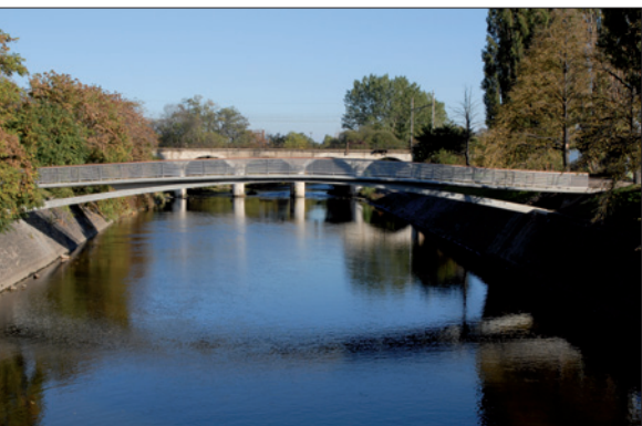
Obr. 1. Lávka – denní pohled
