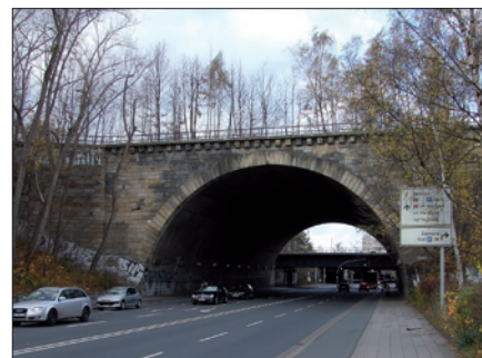
Obr. 3. Fotografie jižního portálu východní soustavy – oblast 1, 2
