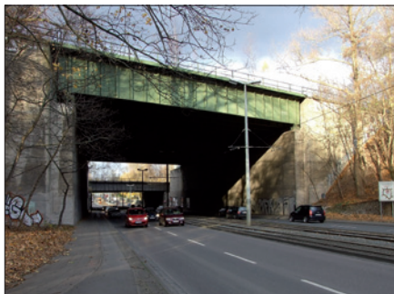
Obr. 4. Fotografie jižního portálu západní soustavy – oblast 11, 12
