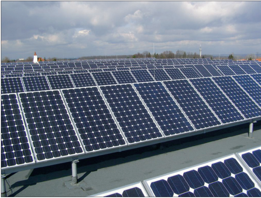
Obr. 3. Hala Hovorčovice (instalovaný výkon 87,48 kW); na tuto střechu bylo použito celkem 486 panelů Sunnywatt 180 Wp; tato elektrárna ročně vyrobí zhruba 87 480 kW·h
