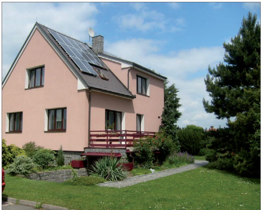
Obr. 4. Dům ve Slatiňanech (instalovaný výkon 3,6 kW); na tuto střechu bylo použito celkem dvacet panelů Sunnywatt 180 Wp; tato elektrárna ročně vyrobí zhruba 3 600 kW·h
