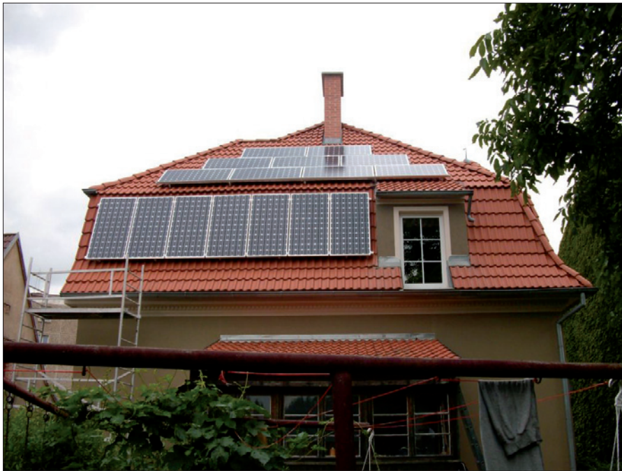
Obr. 5. Žatec (instalovaný výkon 2,88 kW); na tuto střechu bylo použito celkem šestnáct panelů Sunnywatt 180 Wp; tato elektrárna ročně vyrobí zhruba 2 880 kW-h
