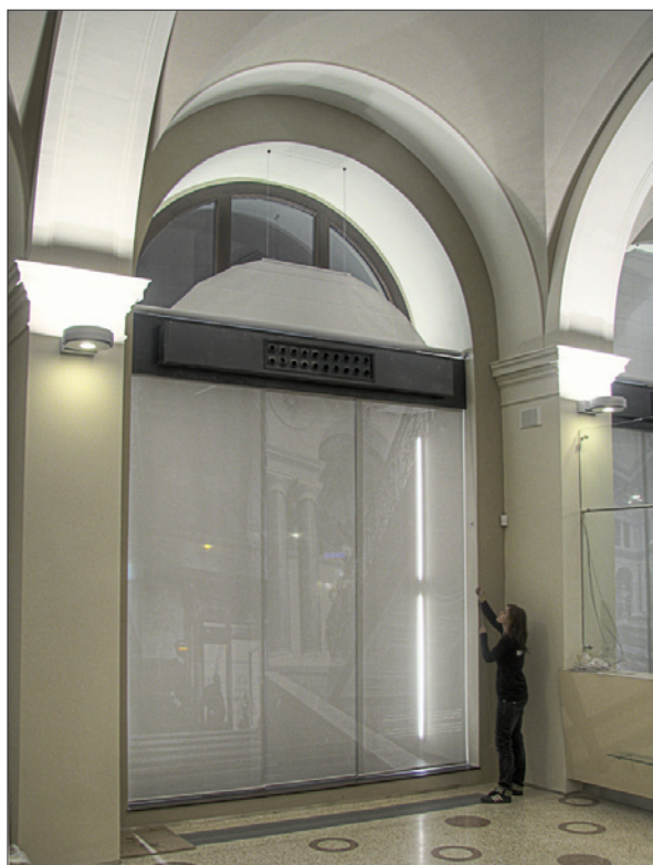
Obr. 8. Posuvné stínicí panely a unikátní klenbová roleta z materiálu Screen (Palác Rytířská, Praha; realizace: Adrems s. r. o., 12/08)
