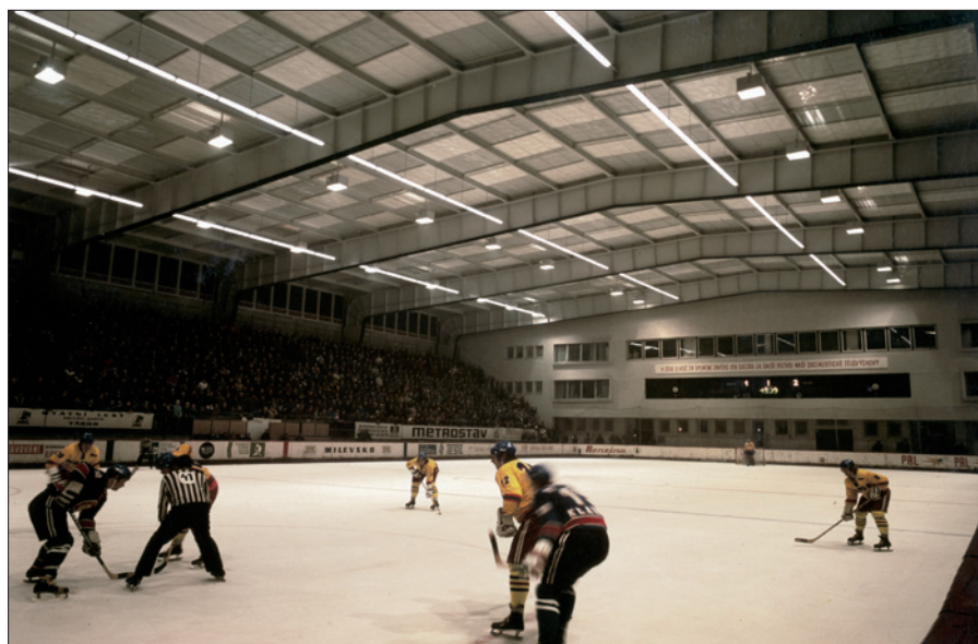
Obr. 5. Sportovní hala v Táboře (1974) osvětlená halogenidovými výbojkami Tesla RVI 3 500 W, 3 500 K, R_a = 65 , světelný tok 350 klm (vývoj Ing. Dvořáček, Tesla Holešovice) a svítidla OSP Tábor (návrh osvětlení a konstrukce svítidla Ing. J. Novotný, Tesla Holešovice) a zářivkami Tesla 80 WB ve svítidlech Elektrosvit 3010.05; naměřené parametry osvětlení byly na úrovni evropských hal pro prvoligový hokej, příkon však byl menší, ovšem při horší variabilitě osvětlení
