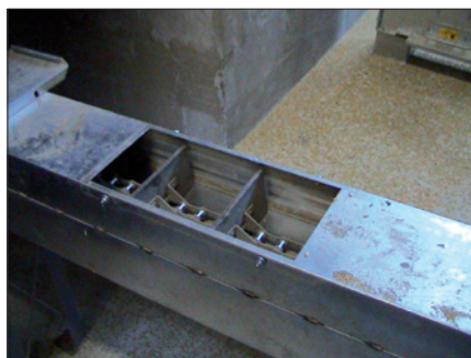
Obr. 13. Pohled na redlerový dopravník se sejmutou částí krytu transportního prostoru (zdroj: Jiří Grepl, revizní technik elektro, Prostějov)
