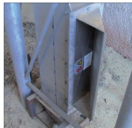
Obr. 17. Pohled na membránu odlehčení výbuchu v elevátoru (zdroj: Jiří Grepl, revizní technik elektro, Prostějov)
