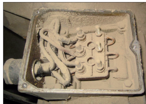
Obr. 23. Ukázka stavu svorkovnice elektromotoru v objektu s hořlavým prachem (zdroj: Jiří Grepl, revizní technik elektro, Prostějov)
