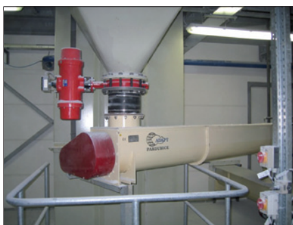
Obr. 16. Pohled na systém pro potlačení výbuchu umístěný mezi zásobníkem a šnekovým dopravníkem (zdroj: Jiří Grepl, revizní technik elektro, Prostějov)
