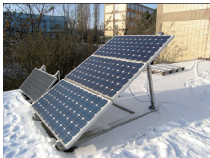
Obr. 1. PV panely s pevným stojanem instalované na ČZU v Praze
