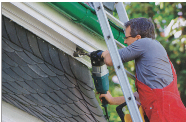
Obr. 4. Vrtáním na jádro se nejprve vytvoří zvenčí otvor do vnitřního prostoru objektu
