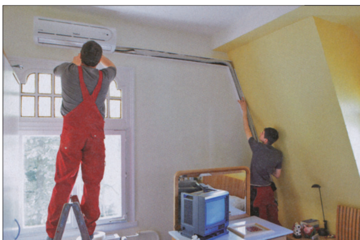
Obr. 1. Pro instalaci a uvedení do provozu děleného klimatizačního přístroje plug-&-play není již třeba ani osvědčení pro práce s chladivem, ani speciální nářadí
