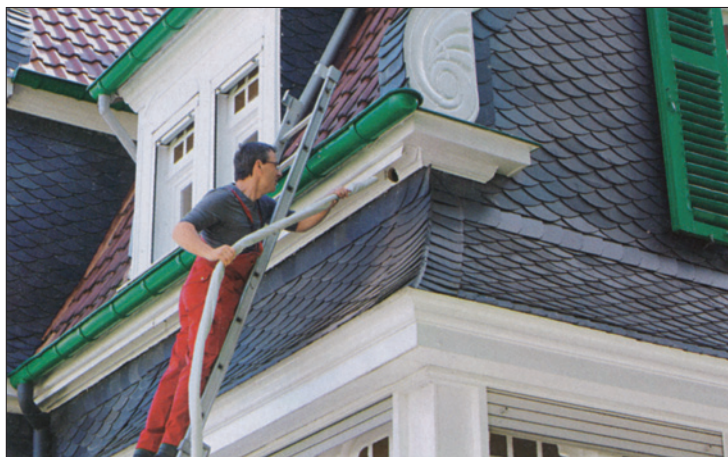
Obr. 5. Kombinované vedení, sestávající z chladiva a elektrických vodičů, i izolace potřebná pro tento účel se prostrčí připraveným otvorem
