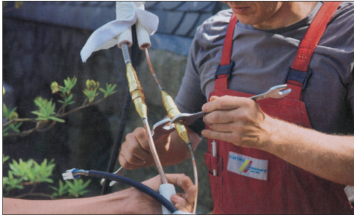
Obr. 8. Požadované prodloužení pro vnější prostor se vytvoří pružným spojením dvou kombinací vedení
