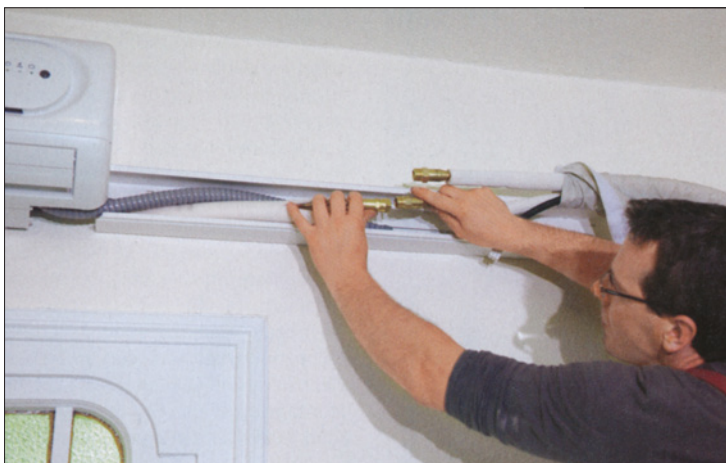
Obr. 7. Vedení se jednoduše zasunou do sebe, resp. se sešroubují
