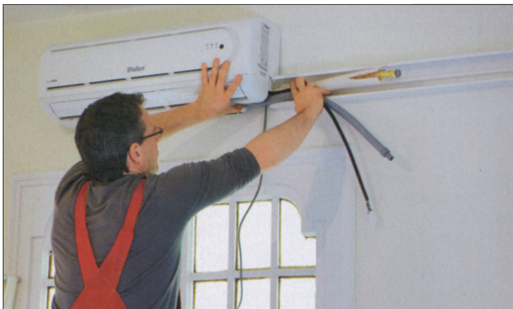
Obr. 6. Ve vnitřním prostoru se namontuje klimatizační přístroj na příslušnou desku (součást dodávky) a do kabelových kanálů se zasunou přípojky vedení
