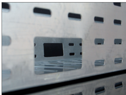
Obr. 2. Kabelový žlab Jupiter - detail kabelových průchodů
