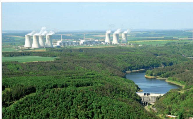
Jaderná elektrárna Dukovany
