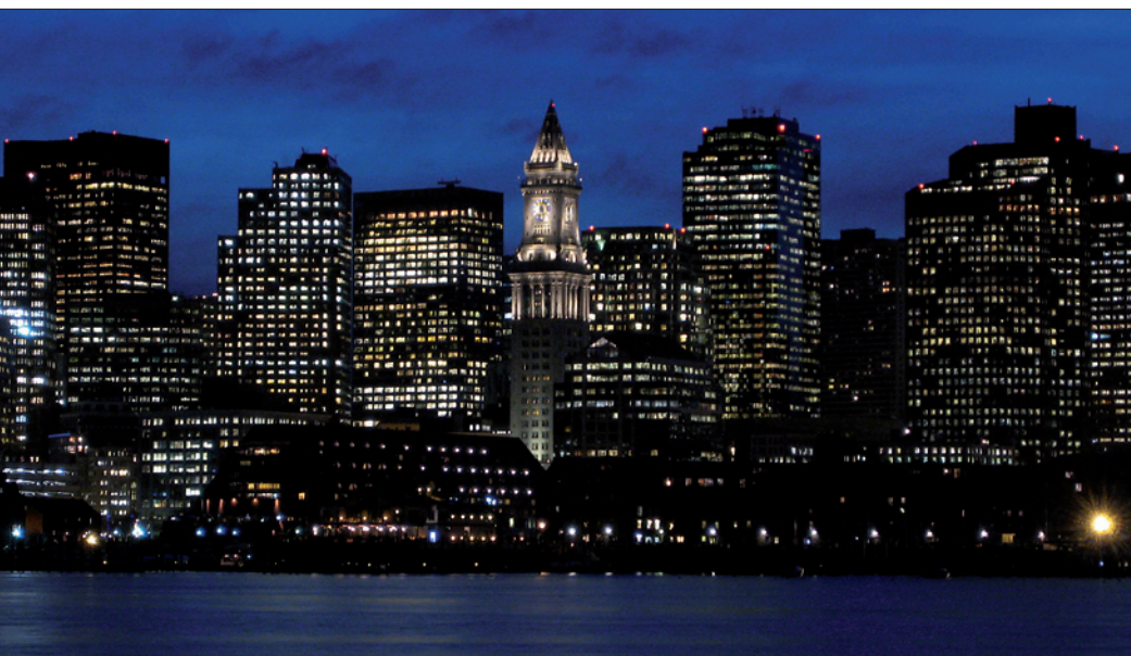
Obr. 1. Marriot Custom House Tower – celkový pohled
