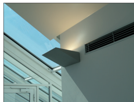
Obr. 4. Detail umiestnenia svietidla Wall MT 70W s paticou G12
