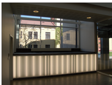
Obr. 5. Svetelná polstena vytvorená svietidlami Basic T5 28W za opálovým sklom
