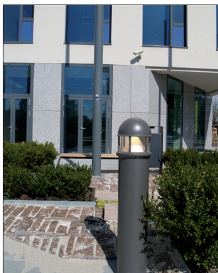
Obr. 6. Pohľad na svetelné stĺpiky Beacon Bollard so zdrojom MT 70W pri vstupe do budovy Nordica
