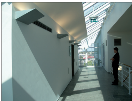
Obr. 3. Svietidlá Wall MT 70W osadené na stenách 6. podlažia
