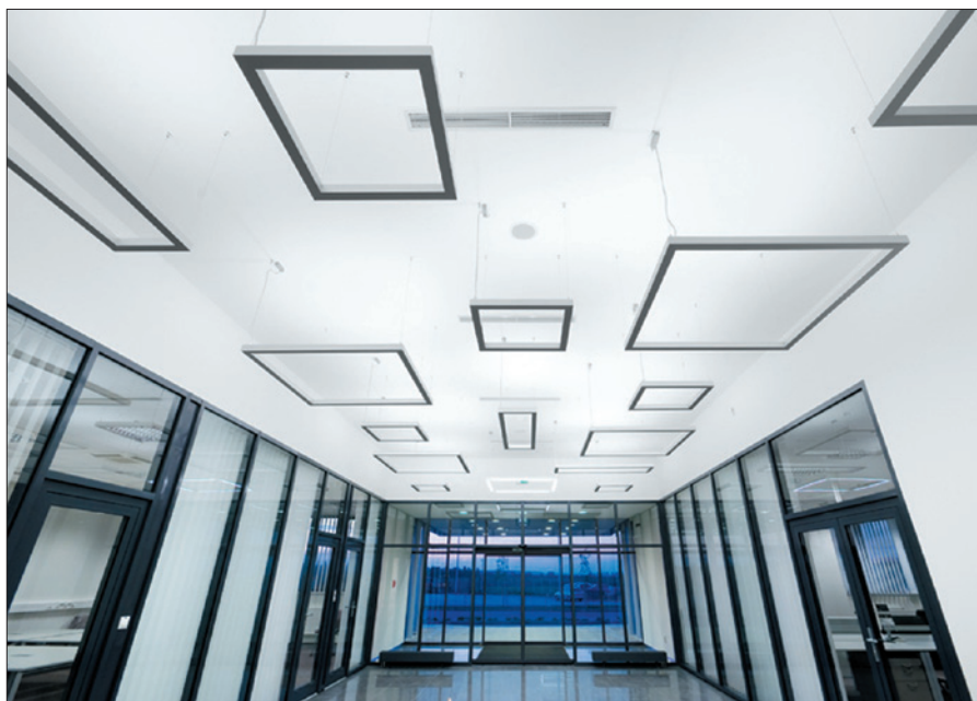
Obr. 4. Svetidlá Wega-Frame vo vstupnej hale závodu Sony
