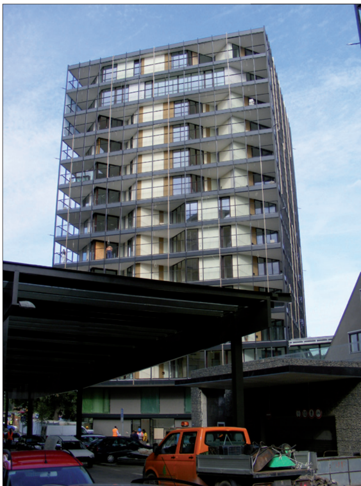
Obr. 1. Budova obytného komplexu Central Park, Praha Žižkov, ve které je instalován posuzovaný světlovod
