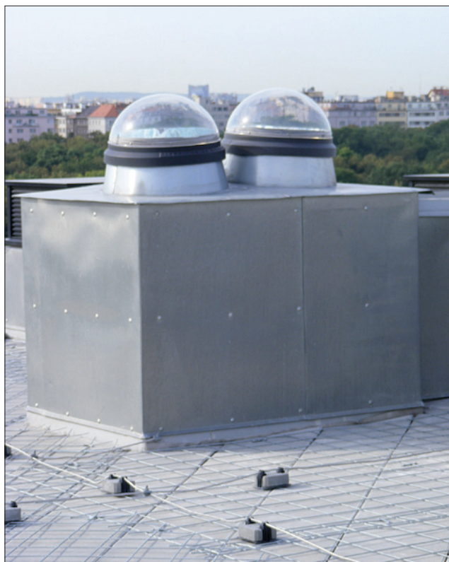
Obr. 2. Ukázka nástřešní části realizovaného světlovodu
