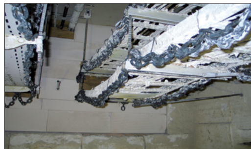
Obr. 3. Kabelový nosný systém po zkoušce
