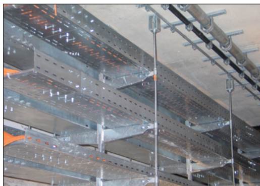
Obr. 1. Kabelový nosný systém před zkouškou požární odolnosti
