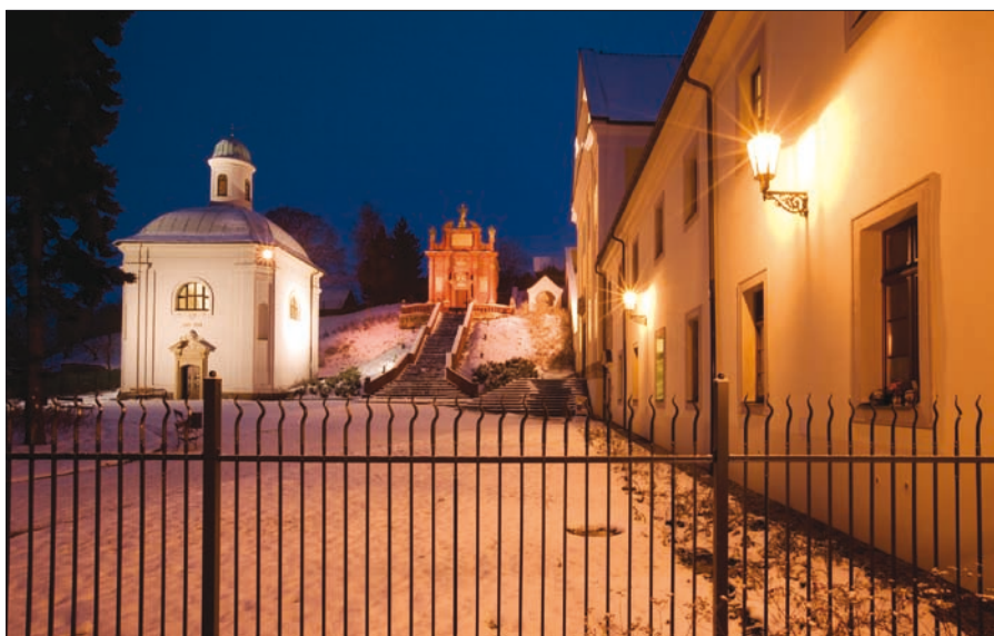
Obr. 2. Venkovní pohled na kapli sv. Floriána s kostelem vpravo (v pozadí Einsiedelská kaple), svítidla Exterieur
