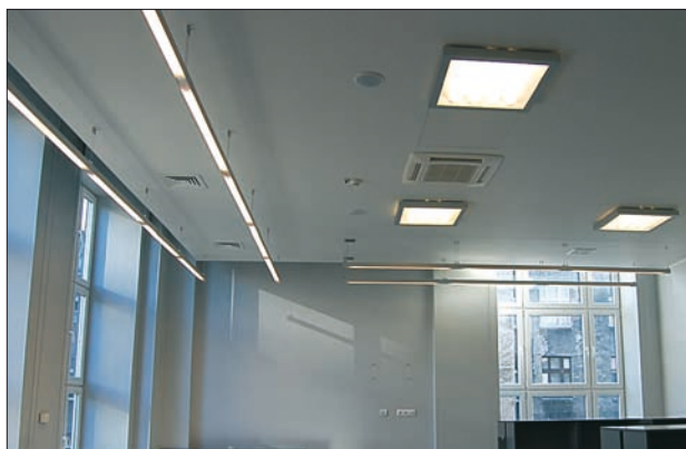
Obr. 9. Svietidlo Wega-A-Module + Wega-C (kancelária)
