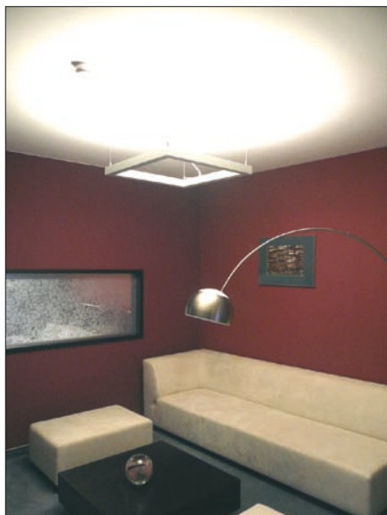
Obr. 1. Svietidlo Wega-A-Frame 4x 24 W (Hotel Magnus)
