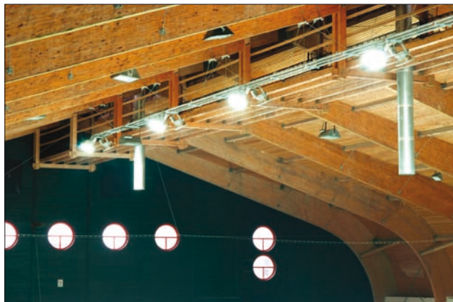
Obr. 4. Světlomety Ray jsou doplněny zachovaným původním osvětlením, což umožnilo udržet náklady na rekonstrukci v přijatelných mezích
