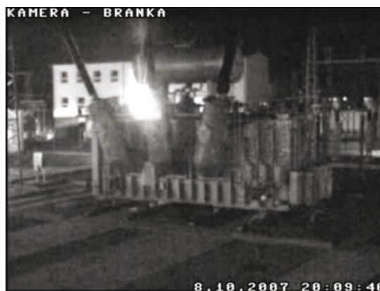
Obr. 2. Transformátor z obr. 1 viděný kamerovým systémem
