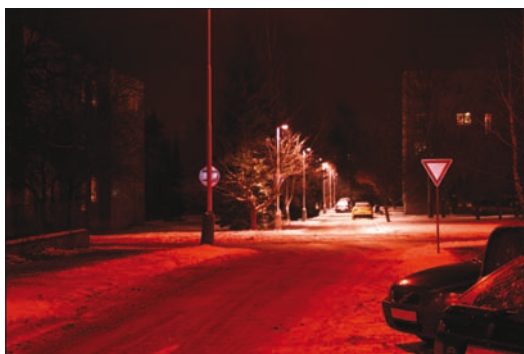
Obr. 2. Brjanská ulice, Kladno – pohled z části osvětlené vysokotlakými sodíkovými výbojkami do části se systémem CosmoPolis
