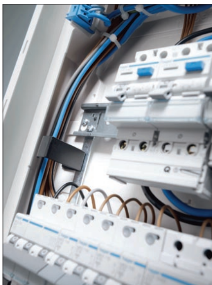
Obr. 2. V bočních skříňkách zvětšený prostor s integrovanými příchytkami pro vodiče
