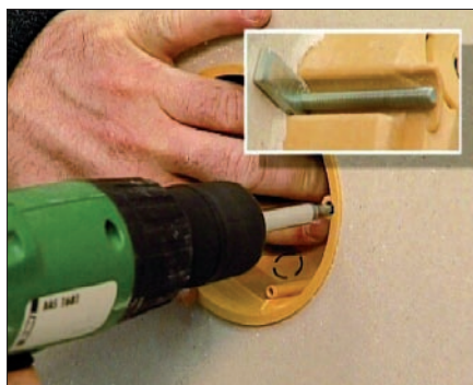
Obr. 1. Detaily uchycení krabice klasickým postupem – šroubek s patkou
