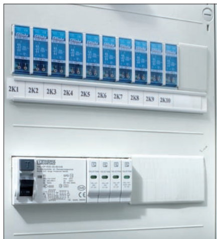
Obr. 1. Přepětová ochrana s chráničem VAL-CP-RCD
