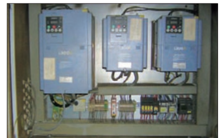
Obr. 2. Pohled do vnitřku se třemi měniči frekvence
