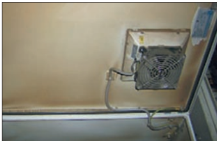
Obr. 3. Aktivní větrák ve dveřích rozváděče
