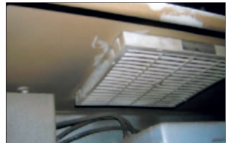
Obr. 4. Deforovaná výstupní mřížka
