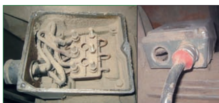
Obr. 2. Ukázka stavu svorkovnice elektromotoru v objektu s hořlavým prachem
