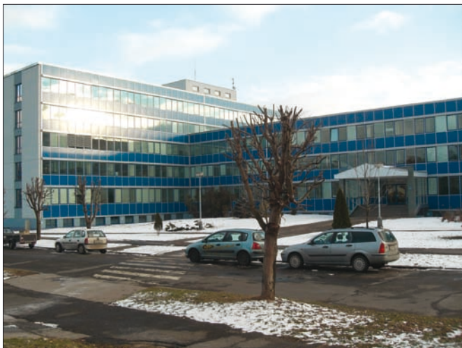
Obr. 1. Budova ÚTIA před několika desítkami let (nahore) a její současná podoba po rekonstrukci (dole)
