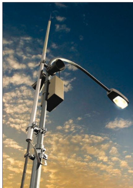
Obr. 8. Poplachový rozhlas na lampě v ochranném prostoru jímací tyče
