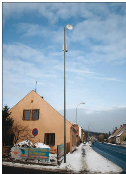
Obr. 2. Aplikace využitá jako jímáč pro ochranu objektu
