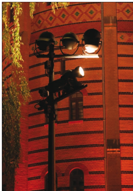
Obr. 6. Detail sloupu osazeného světlomety
