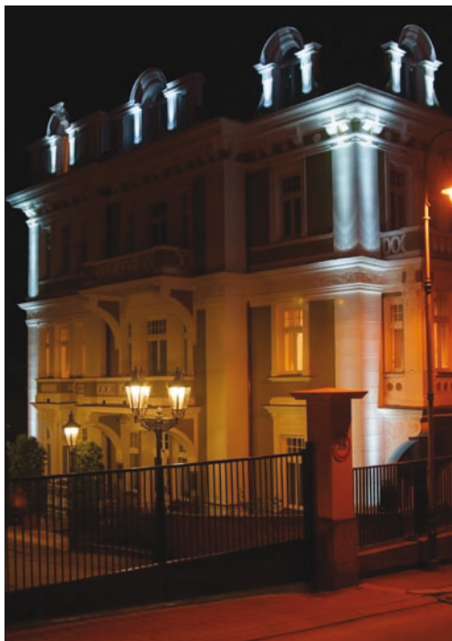
Obr. 1. Celkový pohled na budovu lázeňské vily Livia
