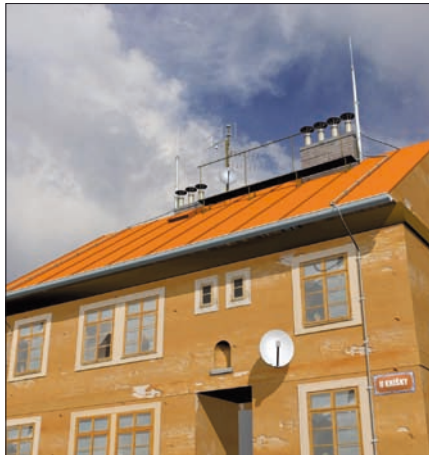
Obr. 9. Izolovaný hromosvod se dvěma jímáči a čtyřmi izolovanými svody s využitím vodiče HVI light
