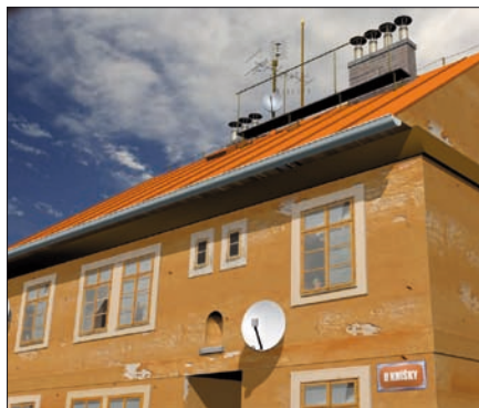
Obr. 7. Objekt s plechovou střechou a nedostatečně chráněnými anténami a vnitřní instalací
