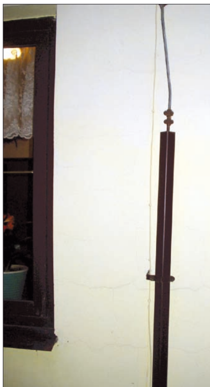
Obr. 5. Montážní chyba – ohrožení vnitřní instalace bleskovým proudem
