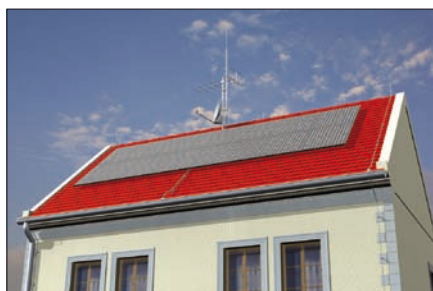
Obr. 3. Izolovaný hromosvod – klasický chráněný štít s izolovaným svodem od vykryvacího jímače
