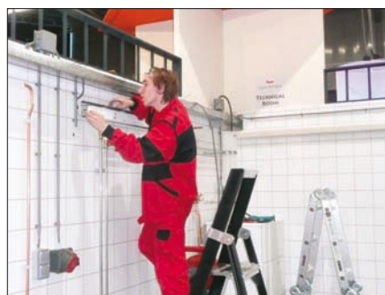
Obr. 2. Elektrikář z ČR při instalaci svítidla
