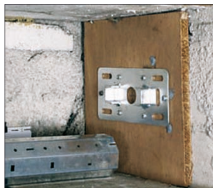
Obr. 3. Ložisko na straně pohonu vyrovnat a namontovat
