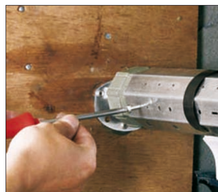
Obr. 10. Podélně vyrovnat posunováním pouzdra válce a nakonec zajistit krátkým šroubem
