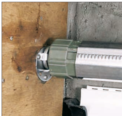
Obr. 8. Zasunout pouzdro válce do hřídele
