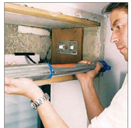
Obr. 6. Zasunout motor do navíjecí hřídele
