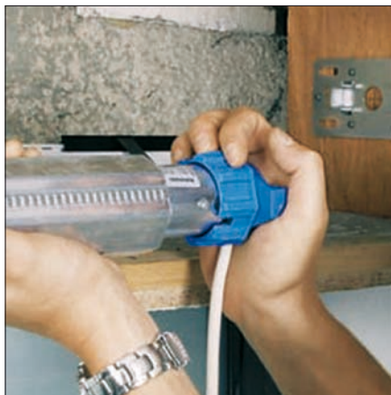
Obr. 7. Vsunout hřídel na adaptér až k dorazu
