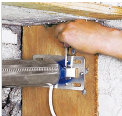
Obr. 9. Hřídel zavěsit do ložiska na straně pohonu a zajistit závlačkami
