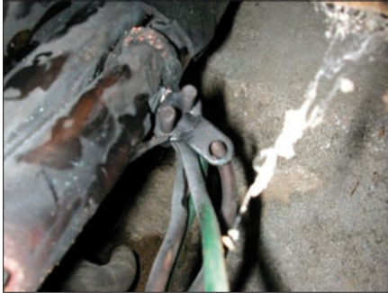
Obr. 4. Příklad provedení neoprávněného odběru – dvě narušené žíly a spořič
