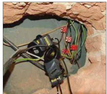
Obr. 6. Příklad neoprávněného odběru v pěstírně marihuany
