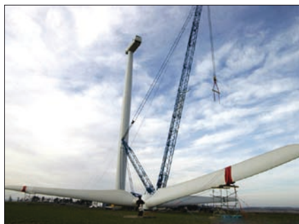
Obr. 8. Výstavba VE Pchery (ČR) – před instalací propeleru
