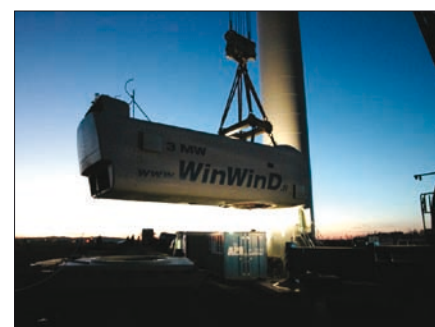
Obr. 7. Výstavba VE Pchery (ČR) – transport gondoly
