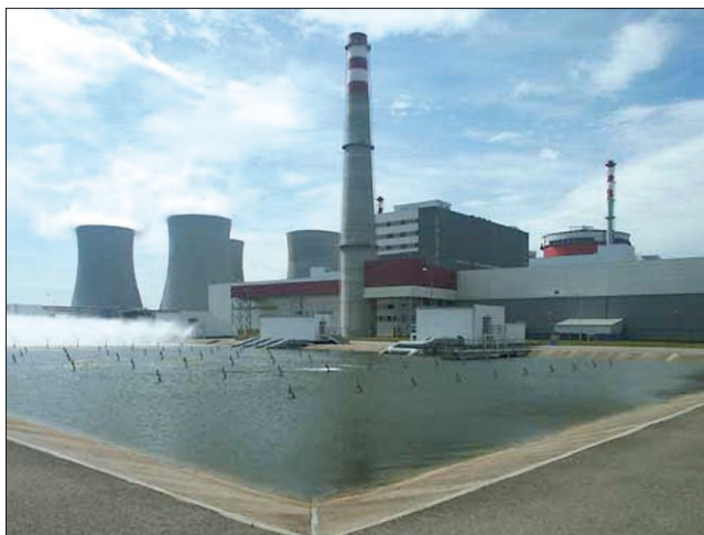
Obr. 1. Jaderná elektrárna Temelín
