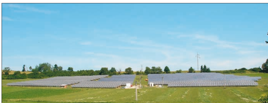
Obr. 1. Pole se solárními panely (sluneční elektrárna Bušanovice)
