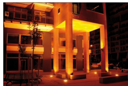
Obr. 5. Zajímavé řešení osvětlení loubí budovy
