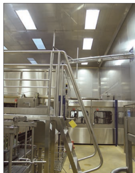
Obr. 7. Osvětlení čistých prostor v plničce minerální vody v CCB, kombinace denního osvětlení a umělého (tmavší otvory jsou světlíky)
