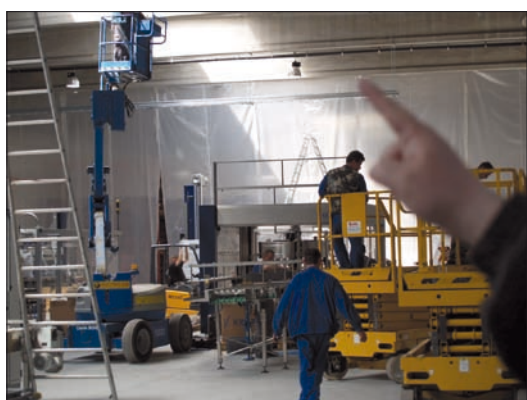
Obr. 5. Výměna výbojkových svítidel za zářivková T5 v CCB
