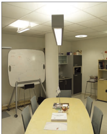
Obr. 3. Osvětlení konferenčního stolu svítidlem s přímo-nepřímým rozložením světelného toku Open Box s manuální i automatickou regulací osvětlení E-sense Fagerhult
