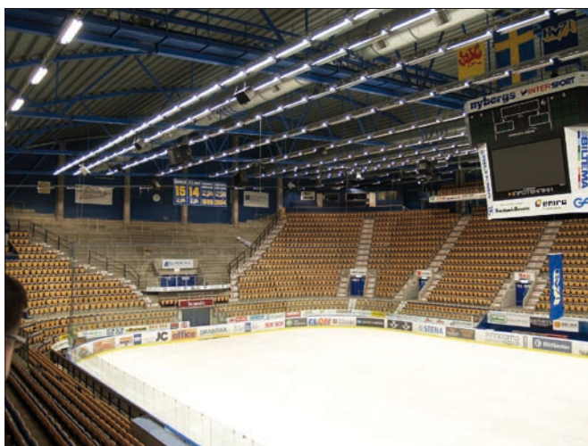
Obr. 1. Osvětlení hokejové haly řízeným osvětlením se zářivkami, klub HV 71, Jonkoping
