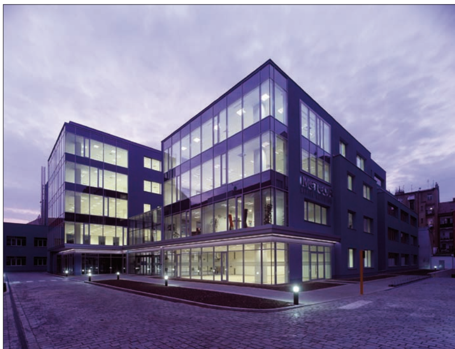
Obr. 2. Kancelářská budova vybavená systémem nouzového osvětlení
