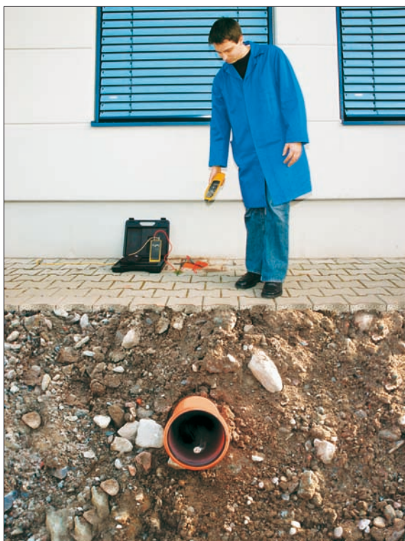
Vyhledávání kabelů uložených v zemi přístrojem Fluke
