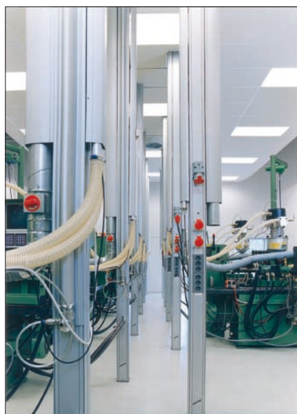
Obr. 4. Řada sloupů InduSign přivádějících média ke strojům
