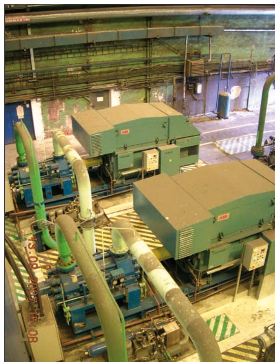
Obr. 3. Pohled na motory AMI
