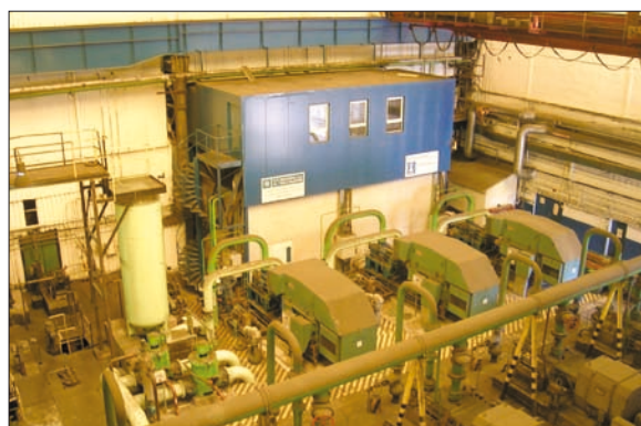
Obr. 1. Celkový pohled na čerpací stanici ostřiku okují
