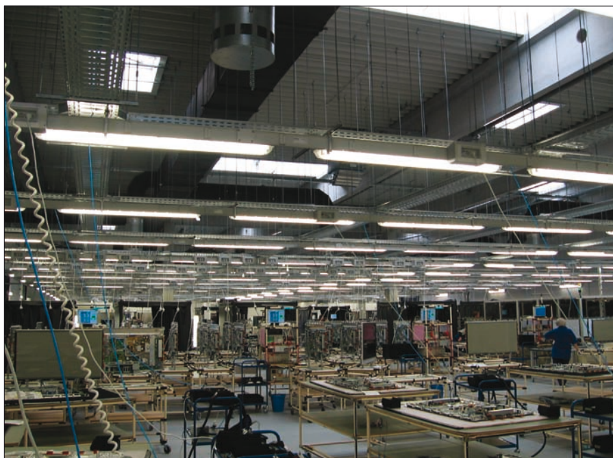
Obr. 4. Napájení mobilních pracovišť z přípojnic typu BD01
