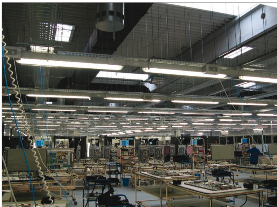
Obr. 4. Napájení mobilních pracovišť z přípojnic typu BD01
