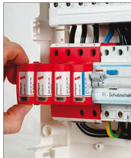
Obr. 7. Vyjímatelné moduly s přepětovou ochranou
